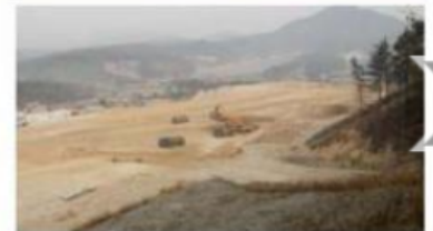
매입한 24만평 부지에 진행중인 토목 공사현장
